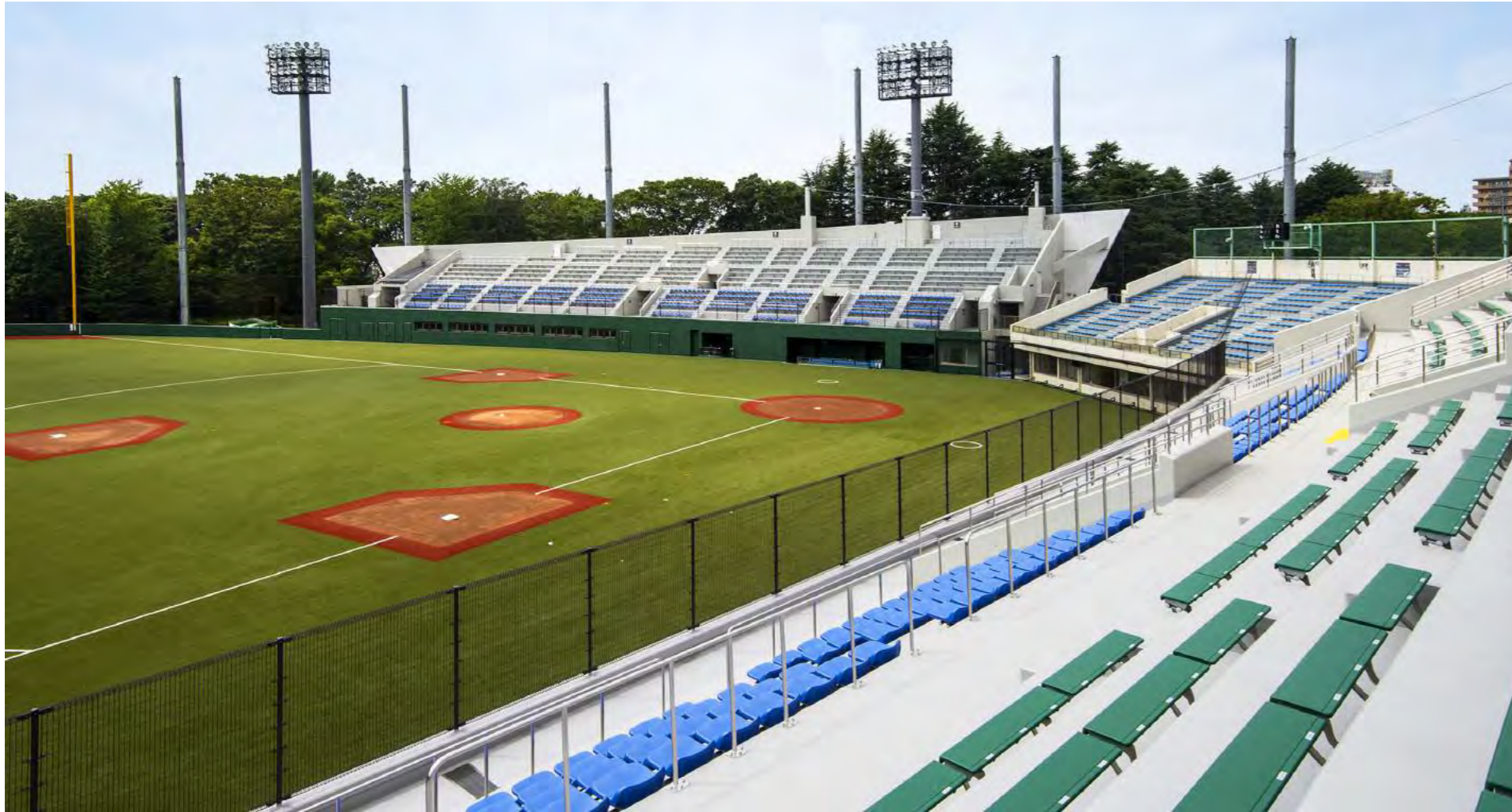
2019年8月30日に増築・改修工事が完了した硬式野球場
