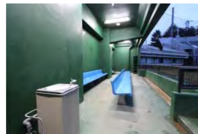
硬式野球場ではベンチや通路などに計6台の冷水機を設置。選手のパフォーマンス向上を支えている
