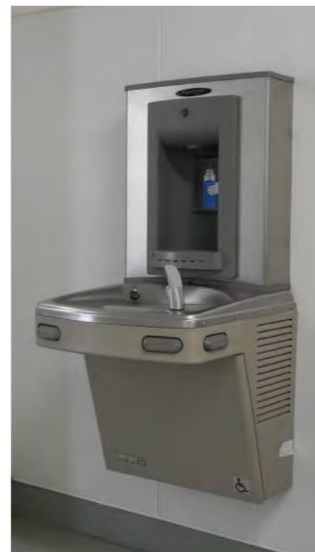
施設各所に設置されたバリアフリー対応型の冷水機。車いすでも利用しやすいよう、高さが調節されている
