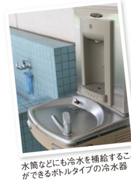
水筒などにも冷水を補給することができるボトルタイプの冷水器
